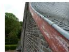
Verschraalde topgevelbeplating
