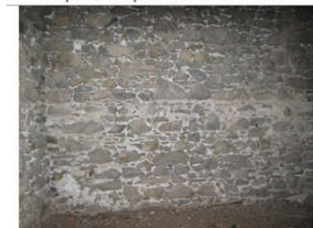
Dettagli dell'interno del campanile che evidenziano la fine della muratura cinquecentesca (il campanile fu sopraelevato tra il 1730 e il 1733)
