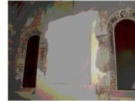
1) Presenza di sali igroscopici su superfici affrescate, con conseguente distacco del film pittorico
