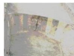
7) Decorazioni pittoriche non restaurate sottoposte a dilavamento
