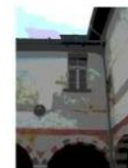
11) Sfogliamento dovuto a percolazione idrica
