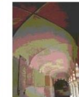
3) Sfogliamento del film pittorico sulle volte
