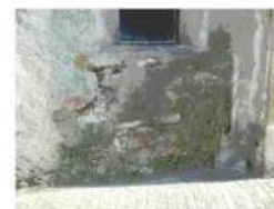
9) Superficie soggetta ad imbibimento idrico
