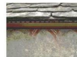
8) Decorazioni pittoriche non restaurate sottoposte a dilavamento
