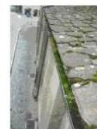
10) Canale di gronda di difficile pulizia. Sottogronda con alcuni travetti degradati
