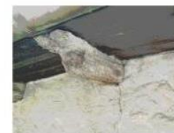
10) Canale di gronda di difficile pulizia. Sottogronda con alcuni travetti degradati
