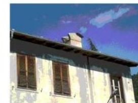
5) Corniglino scoperto con conseguenti infiltrazioni d'acqua
