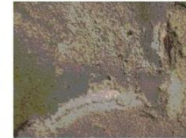
1) Presenza di sali igroscopici su superfici affrescate, con conseguente distacco del film pittorico
