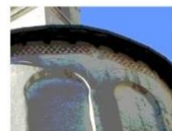
7) Decorazioni pittoriche non restaurate sottoposte a dilavamento
